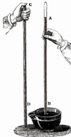
**Figure 1 :** Expérience de Torricelli dite « expérience donnant à voir le vide ». On remplit un tube de mercure, on obture son extrémité puis on le retourne, verticalement, sur une cuve remplie du même liquide. Une fois le tube en place - son ouverture plongée dans le mercure de la cuve - on retire ce qui l'obture et l'on constate que le mercure baisse dans le tube pour se stabiliser à une hauteur de 76 cm.
